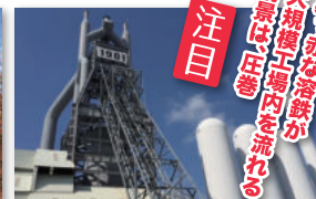
年に1度の起業祭工場見学は大迫力！！ ※一般見学校となります。 日本製鉄九州製鉄所
